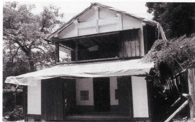
改修工事が行われている牧水生家
