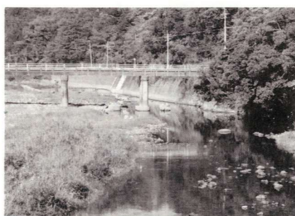
▲幼い頃遊んだ羽坂橋下の坪谷川
