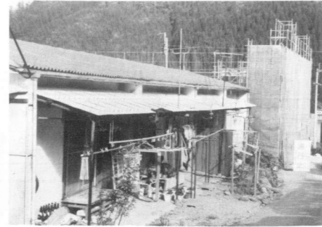
八戸建て替えられる町営住宅
