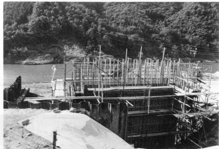
▲切瀬から対岸を結ぶ162mの架橋工事
