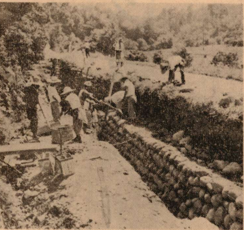
大谷村道改良工事風景
